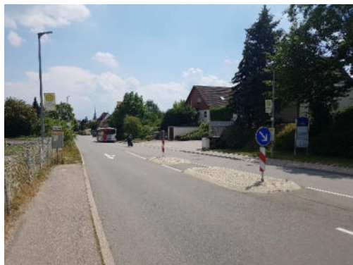
Blick entlang der Nagolder Straße in südliche Richtung zum Ortskern. Unmittelbar vor dem Planareal befindet sich die Bushaltestelle.
