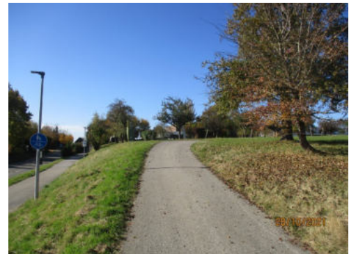
Ansicht der Auffahrt des Wirtschaftsweges zum Grundstück.
