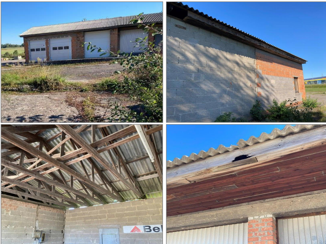
Abb. 15: Teilbereich 9: Außenansichten und Dachkonstruktion der Bestandsgebäude (Fotos: HPC AG 22.09.2023)
