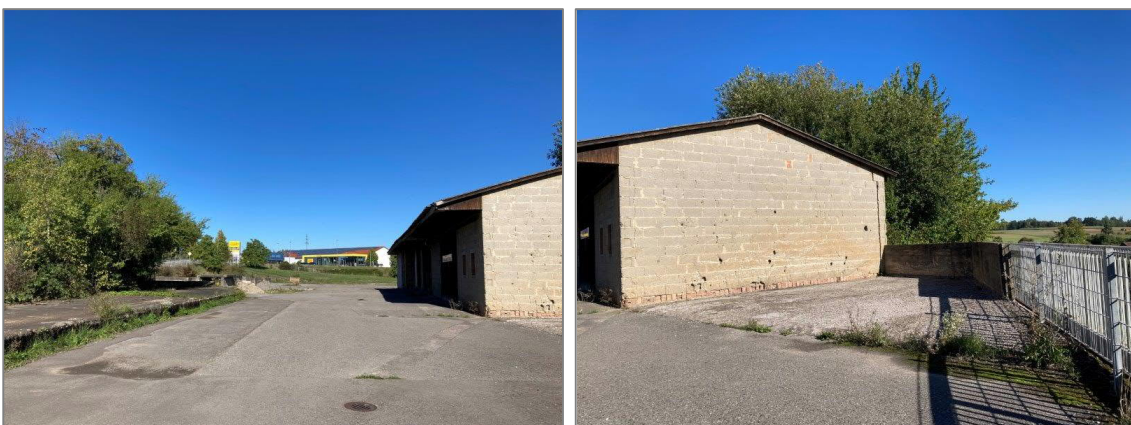
Abb. 7: Teilbereich 2: Eingangsbereich, Flst. Nr. 1844 (Fotos: HPC AG 22.09.2023)
