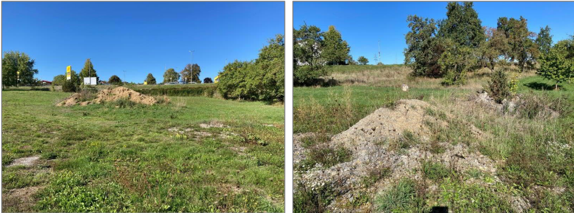
Abb. 11: Teilbereich 5: Ablagerung von Erdmaterial auf der Wiese, Flst. Nrn. 1846 und 1845 (Fotos: HPC AG 22.09.2023)
