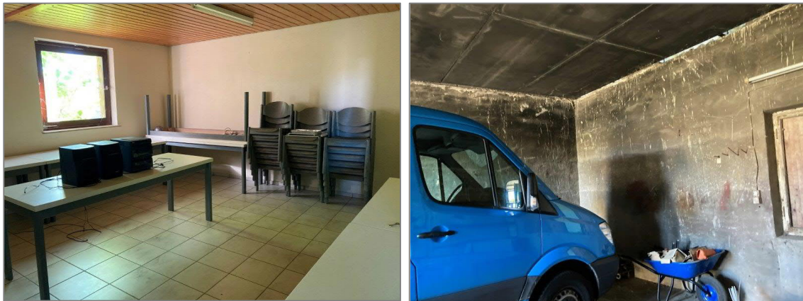
Abb. 16: Teilbereich 9: Innenansichten der Bestandsgebäude (Fotos: HPC AG 22.09.2023)
