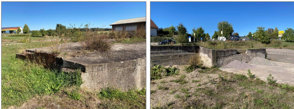
Abb. 8: Teilbereich 3: verbliebene Bodenplatten, Flst. Nrn. 1843/1 und 1844/1 (Fotos: HPC AG 22.09.2023)
